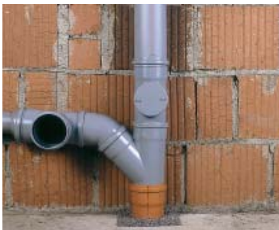
Rohr an der Muffenkante markieren und anschließend das Rohr ca. 10 mm aus der Muffe herausziehen.
