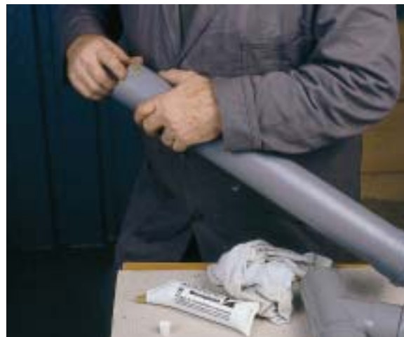
...Gleitmittel auftragen
