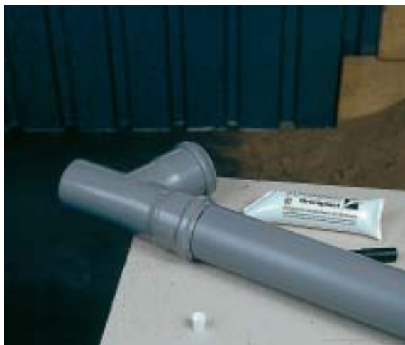
Fertig ist die Verbindung.
